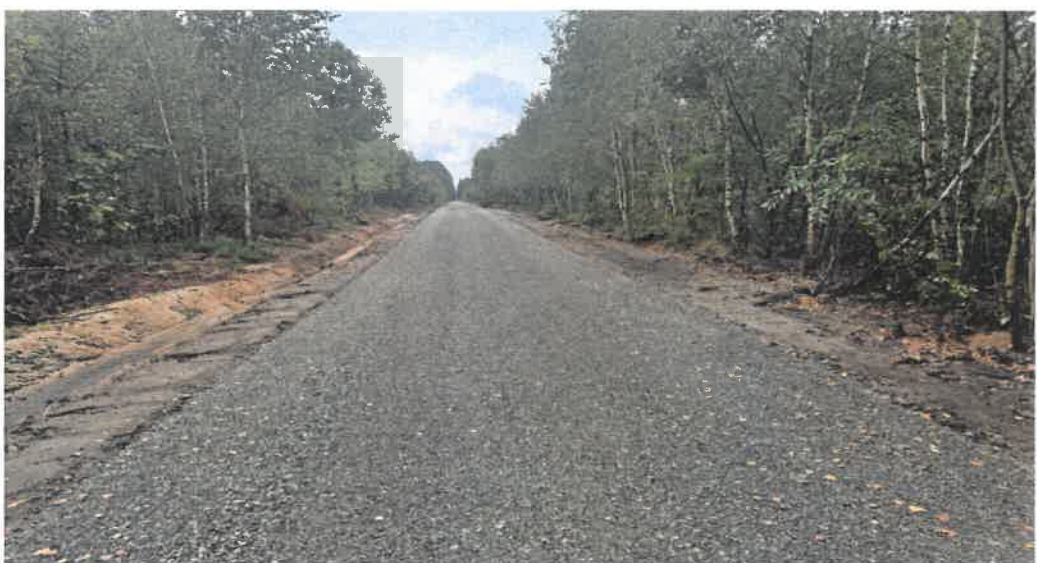
Modernizacja drogi leśnej do Mikołaja w Durdach
