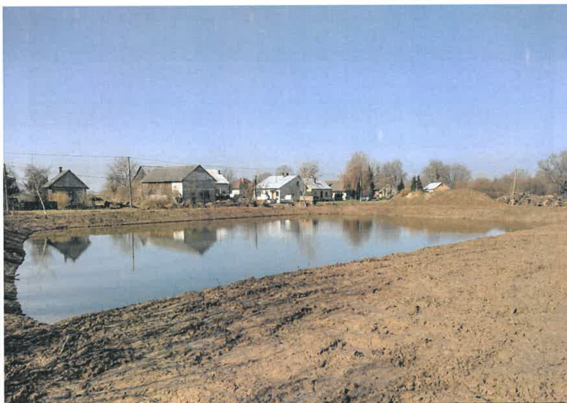
Budowa zbiornika małej retencji w Dymitrowie Małym
