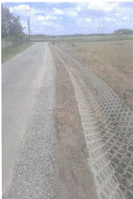
Położenie nawierzchni asfaltowej na ul. Średniówka w Woli Baranowskiej
