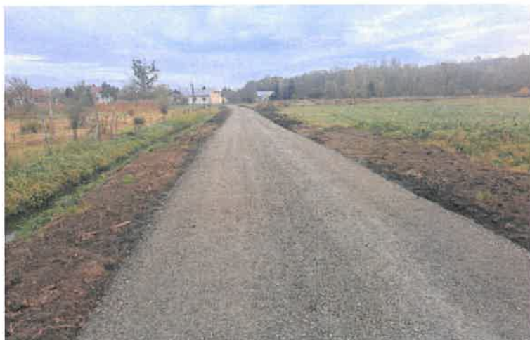
Budowa drogi transportu rolnego w Suchorzowie – pastwisko
