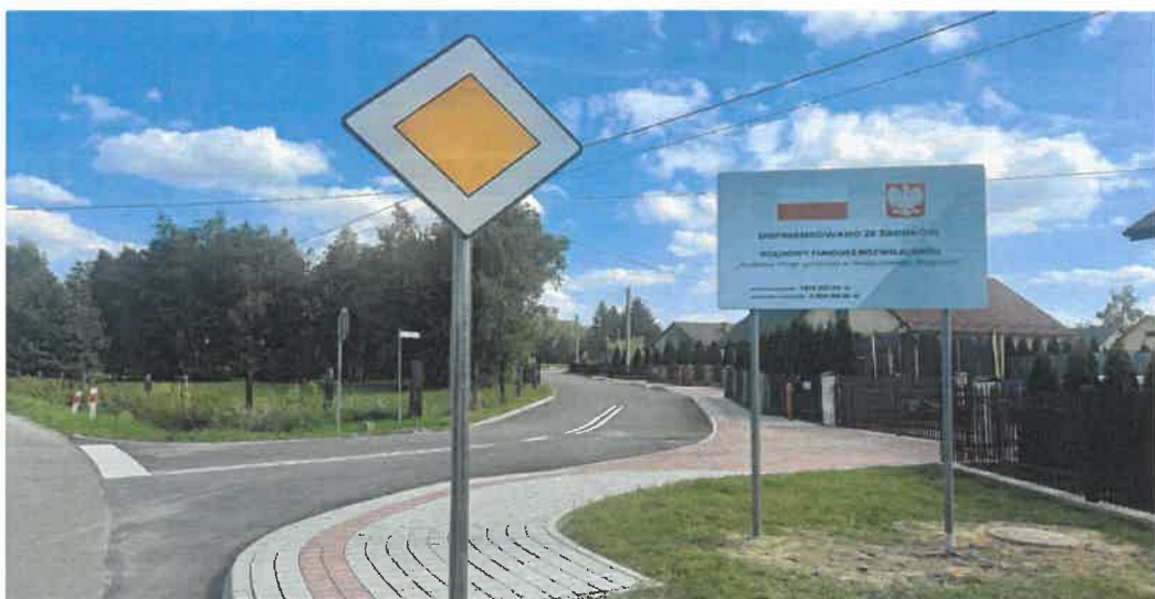
Budowa drogi przez nowe osiedle w Skopaniu
