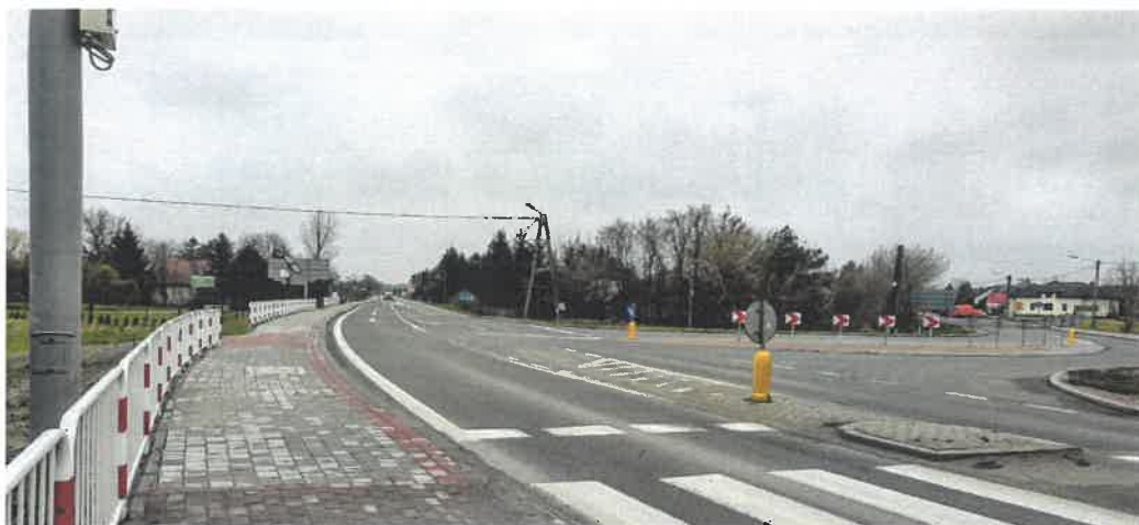
Budowa chodnika przy DW 985 w Baranowie Sandomierskim
