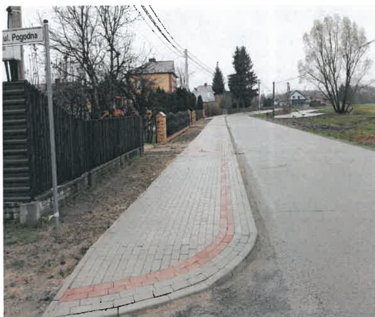
Budowa chodnika przy ul. Urszulin w Knapach
